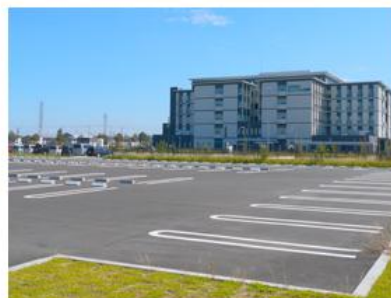
【写真3】駐車場側より
